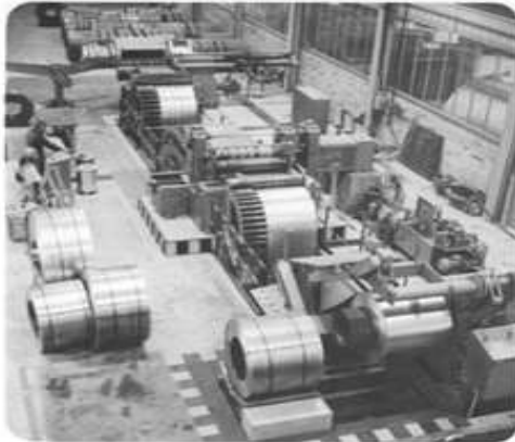
شغل (2) مكائن تقطيع ونفث التبراج تشغل بوساطة منظومة هيدروليكية قريبة المصدر [1]
