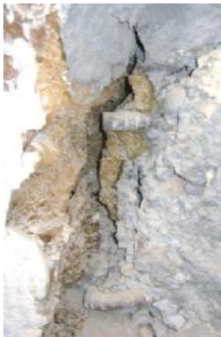
التشققات في الجدار الكونكريتي المسلح تحت الدرج
