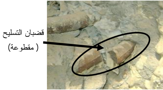
الشكل (8): مخطط يوضح الدوران الحاصل في القاعدة الموشورية والتشققات و قطع قضبان التسليح
