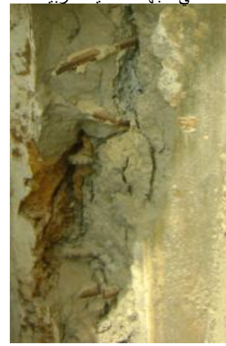
التشققات في الجدار الكونكريتي المسلح تحت الدرج
