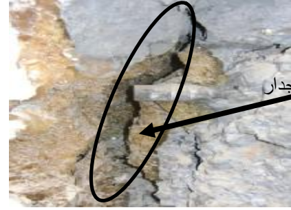
الشكل (8): مخطط يوضح الدوران الحاصل في القاعدة الموشورية والتشققات و قطع قضبان التسليح
