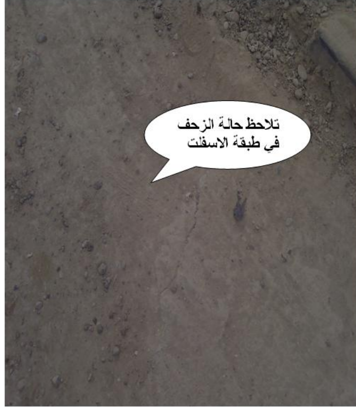
صورة رقم (3) التهشم في الطبقة الاسفلتية تحت حمل المركبات
