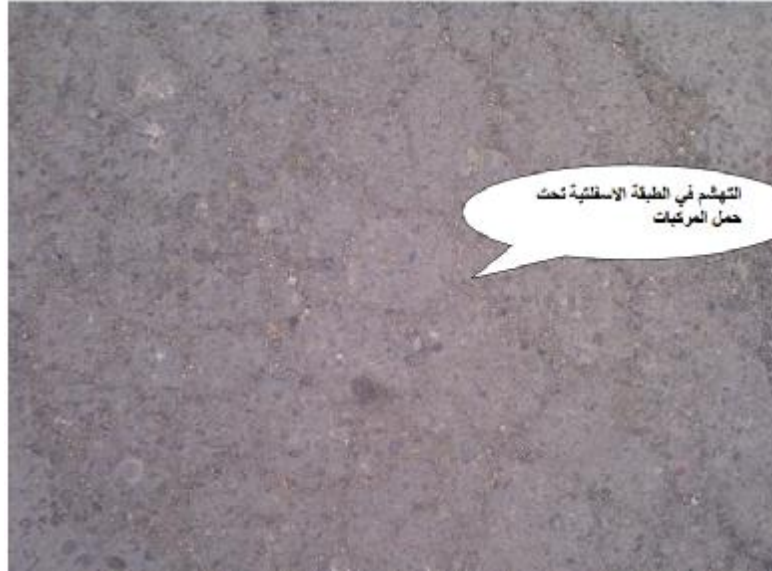
صورة رقم (6) التهشم في الطبقة الاسفلتية تحت حمل المركبات
