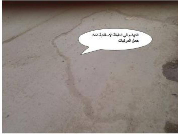
صورة رقم (5) التهشم في الطبقة الاسفلتية تحت حمل المركبات
