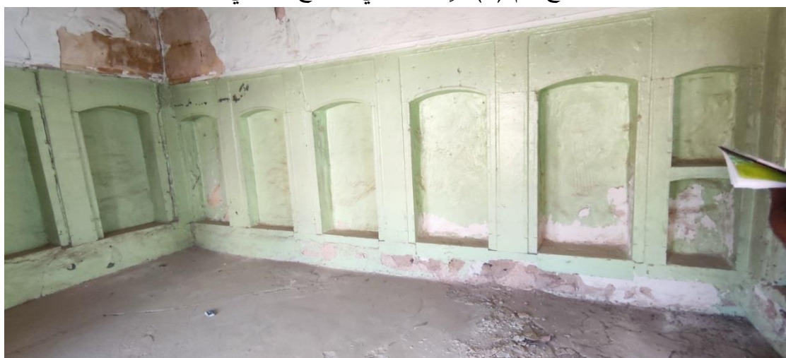
لوح (رقم ٥) خزانات ودخلات داخل الحجرة المطلة على الإيوان الثاني
