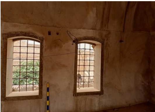
الصورة (٦٠) نافذتان في الجدار الشمالي للغرفة (٢)، تصوير الباحثة
