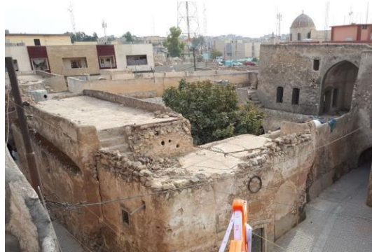
الصورة (٤٥) اسطح دار بخوسيبي، تصوير الباحثة
