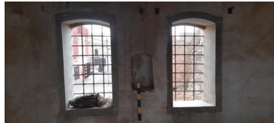
الصورة (٥٩) نافذتان في الضلع الجنوبي تطلان على واجهة الدار، تصوير الباحثة
