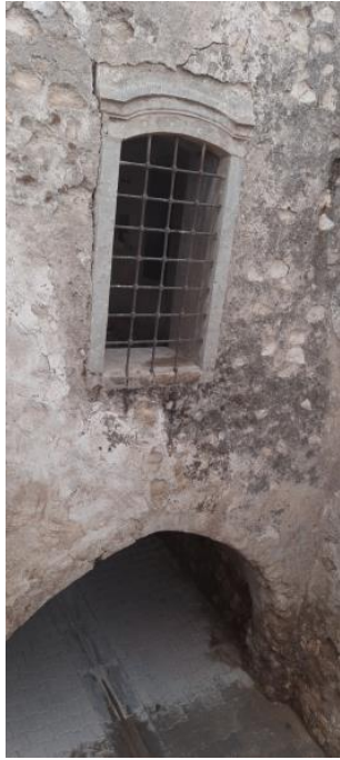
الصورة (٥٤) نافذة الضلع الشمالي للغرفة (١) تعلو القنطرة لدار بخوسيبي، تصوير الباحثة
