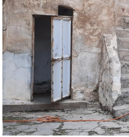
الصورة (١٥) الكنيف لدار بخوسيبي، تصوير الباحثة
