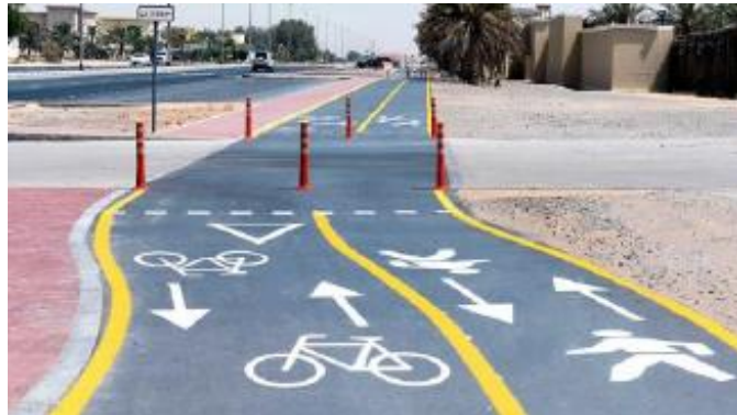
الشكل (9) عزل مسالك حركة المشاة عن مسالك حركة الدراجات الهوائية في دبي. المصدر: Decirmeerachter-voller.com
