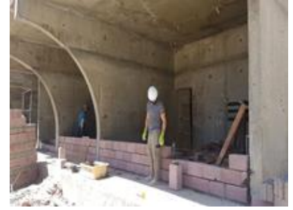
الشكل (17) أعمال البلوك الناري
