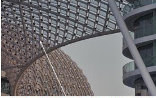
الهيكل القشري الشبكي والذي يشكل القشرة الخارجية للمبنى ويربط المبنى بصرياً
