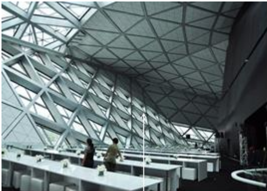
شكل رقم (6) يوضح الهيكل الإنشائي لمشروع Guangzhou Opera House، المصدر: https://www.archdaily.com
