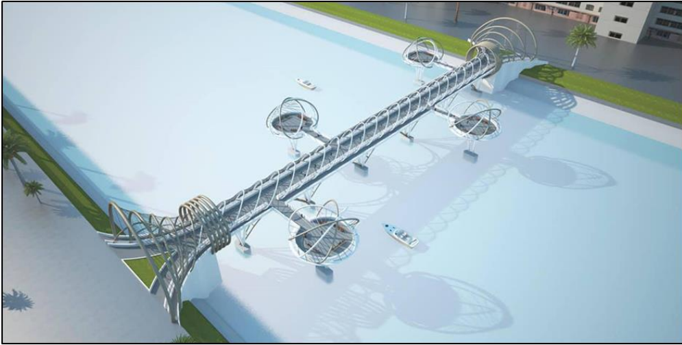
أ- يوضح تصميم الجسر المقترح إذ نلاحظ الجلسات الخارجية عدد 4 ومنطقة تعريف دخول الجسر التي تميزت بهيكل حلزوني
