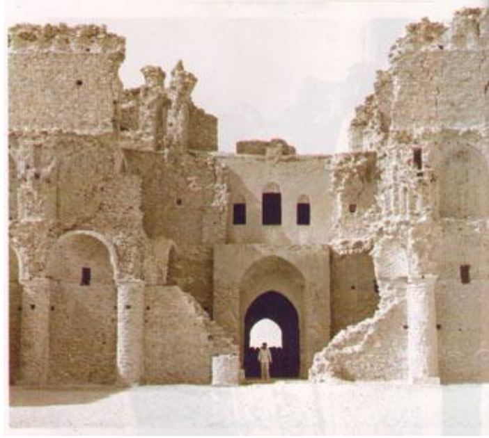
الشكل (٤) تأثير الأمطار على تآكل المونة (حصن الأخضر)
