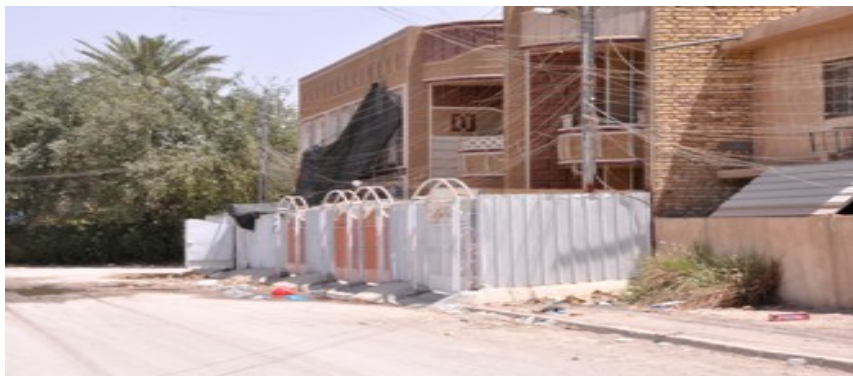
شكل (4): التجاوزات البناء على ارضية المنطقة (محلة 911) /المصدر : الباحثان
