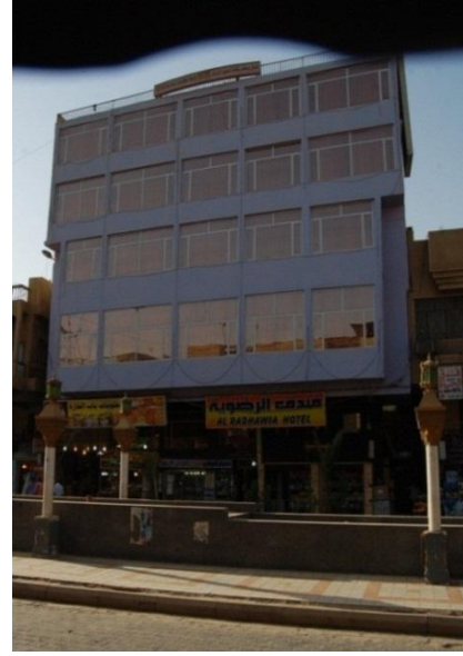
شكل (3) التجاوز في عدد الطوابق – مدينة الكاظمية يجب ان لا يتجاوز 3 طوابق /المصدر: الباحثة
