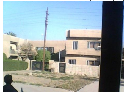
شكل (15) المبنى متعدي على فضاء أرض الجار
