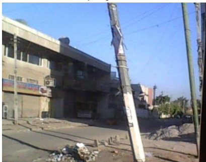
شكل (10) استعمال الرصيف أو جزء من الشارع لخرن مواد البناء
