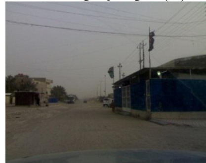
شكل (17) المبنى متعدي على خط تنظيم الشارع - حي البيضاء
