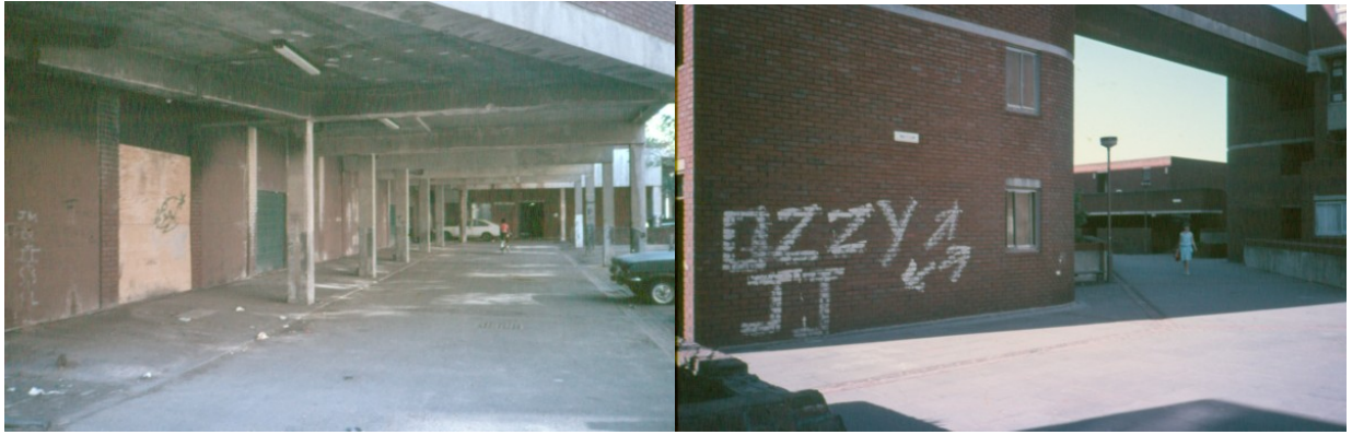
شكل 7 - اعمال تخريب وتشويه للحوائط فوق المنصة وفي مواقف السيارات تحت النصة داخل مجمع سكني في مدينة لندن
