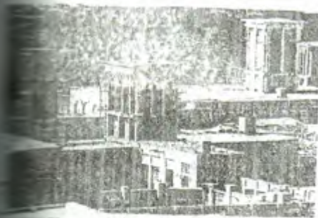
(شكل-9) الملاقف الهوائية ذات الاتجاه الأربعة المنتشرة في مناطق الخليج وايران (حسن فتحي-1988)
