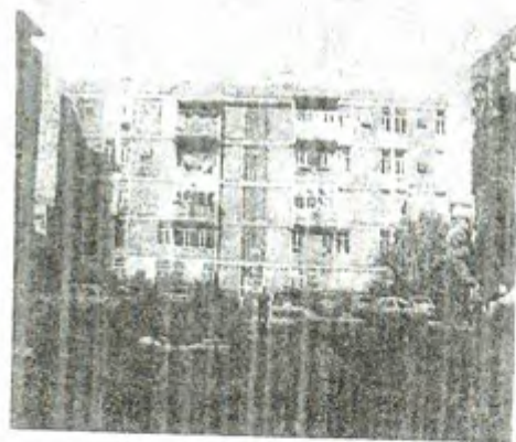
الواجهة الشمالية-الغربية للمبنى السكني وتظهر فيه الفضاءات الصيفية النافذة باتجاه شمال-غربي/جنوب-شرقي
