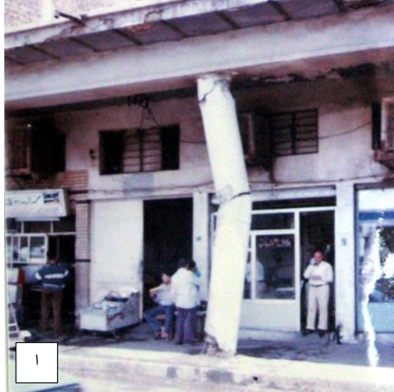
الشكل (5) : الابنية الايلة للسقوط الشكل أ : انهيار جزء من دار سكنية في الفضل وبقاء الجزء الباقي معلقا بالهواء يحتمل السقوط في اية لحظة . الشكل ب : عمود كونكريتي تعرض لاضرار بالغة ، وهو ايل للسقوط في منطقة علاوي الحلة ، بغداد . (المصدر : الباحث)
