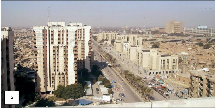
الشكل (4) : خرق خصوصية الدور من المباني المرتفعة الاشكال : أ ، ب ، ج : نماذج لمباني متعددة الطوابق تفتح نوافذها بشكل مباشر على الدور السكنية المنخفضة المجاورة لها في منطقة الفضل (المصدر : الباحث) الشكل د : التباين الشديد بين ارتفاع المباني السكنية المتعددة الطوابق ومجاورتها المنخفضة ، مشرفة عليها بشكل مباشر . شارع حيفا . المصدر : www.baghdad.co.cc
